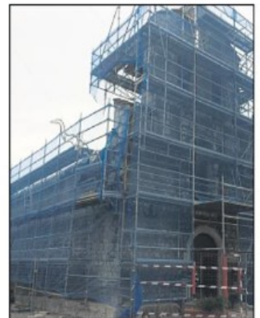
Impressionnante structure métallique pour une vieille dame de pierres qui forment l'église paroissiale. (Photo D. O.)
